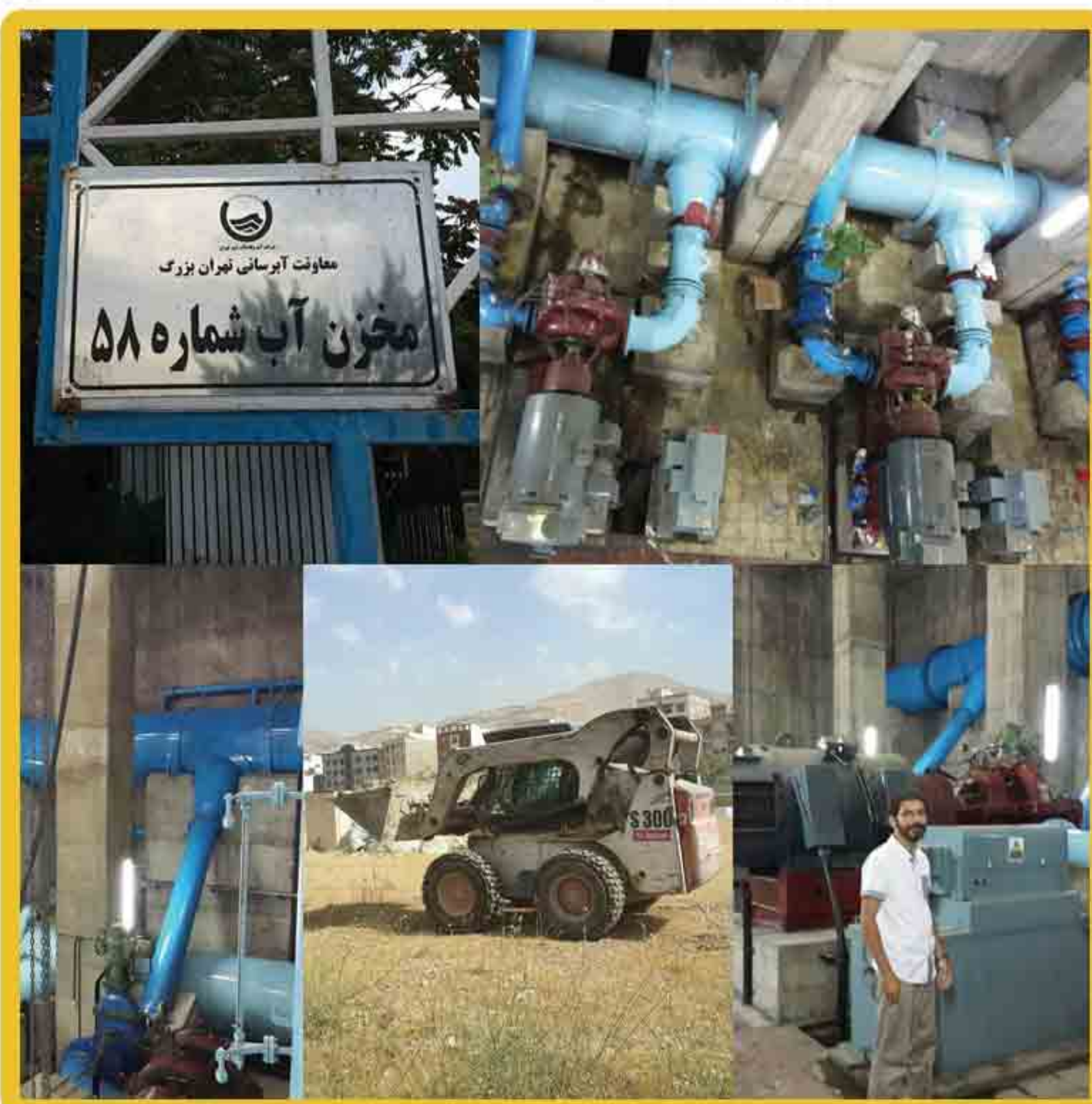
پروژه مخزن آب شماره ۵۸
