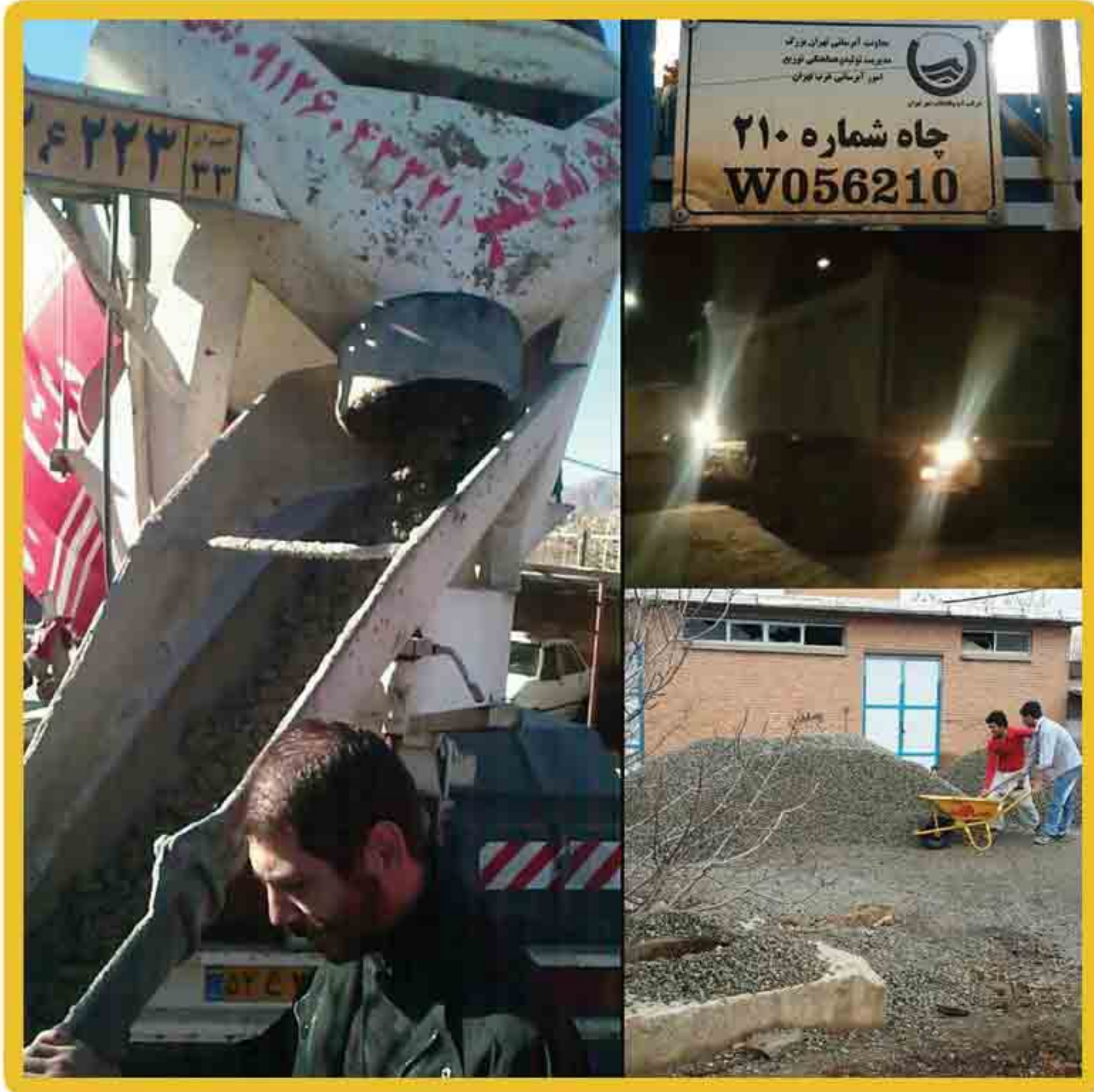
پروژه چاه شماره ۲۱۰
