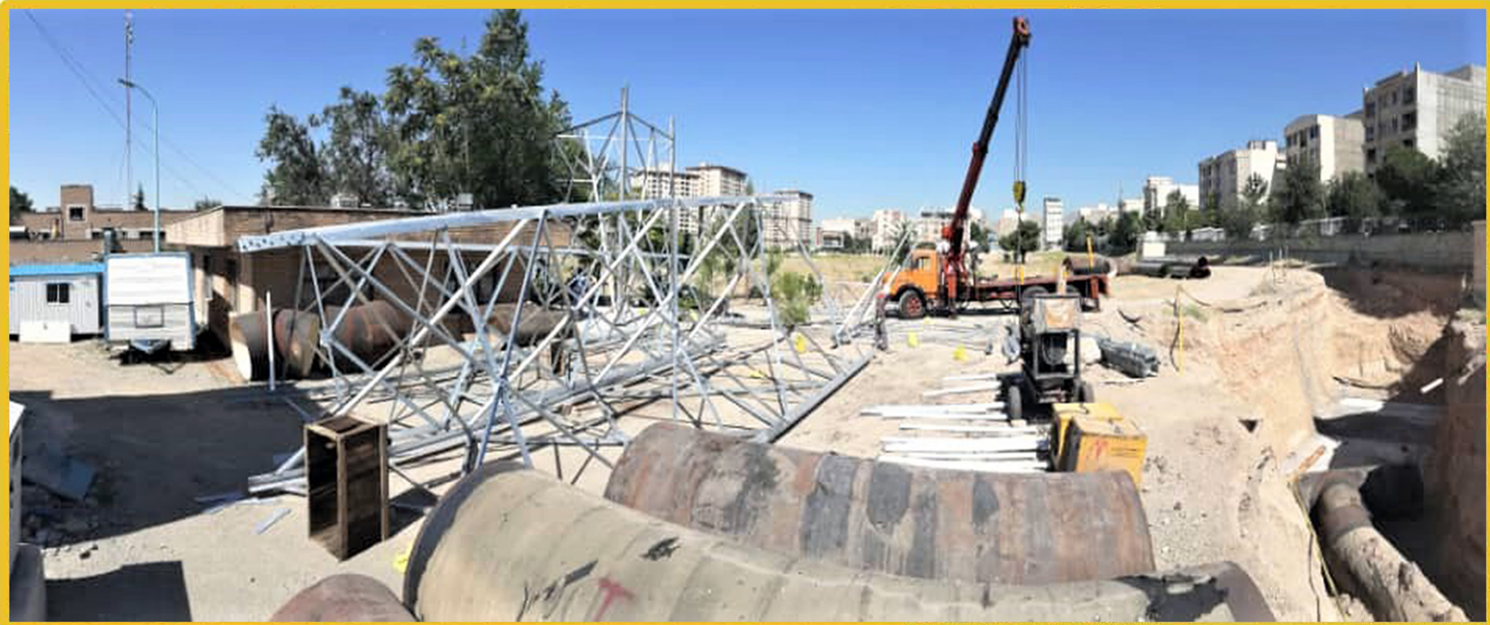
پروژه لوله گذاری مخزن ۴۳ در اقطار ۶۰۰ و ۸۰۰ ، ۱۰۰۰ ، ۱۴۰۰
