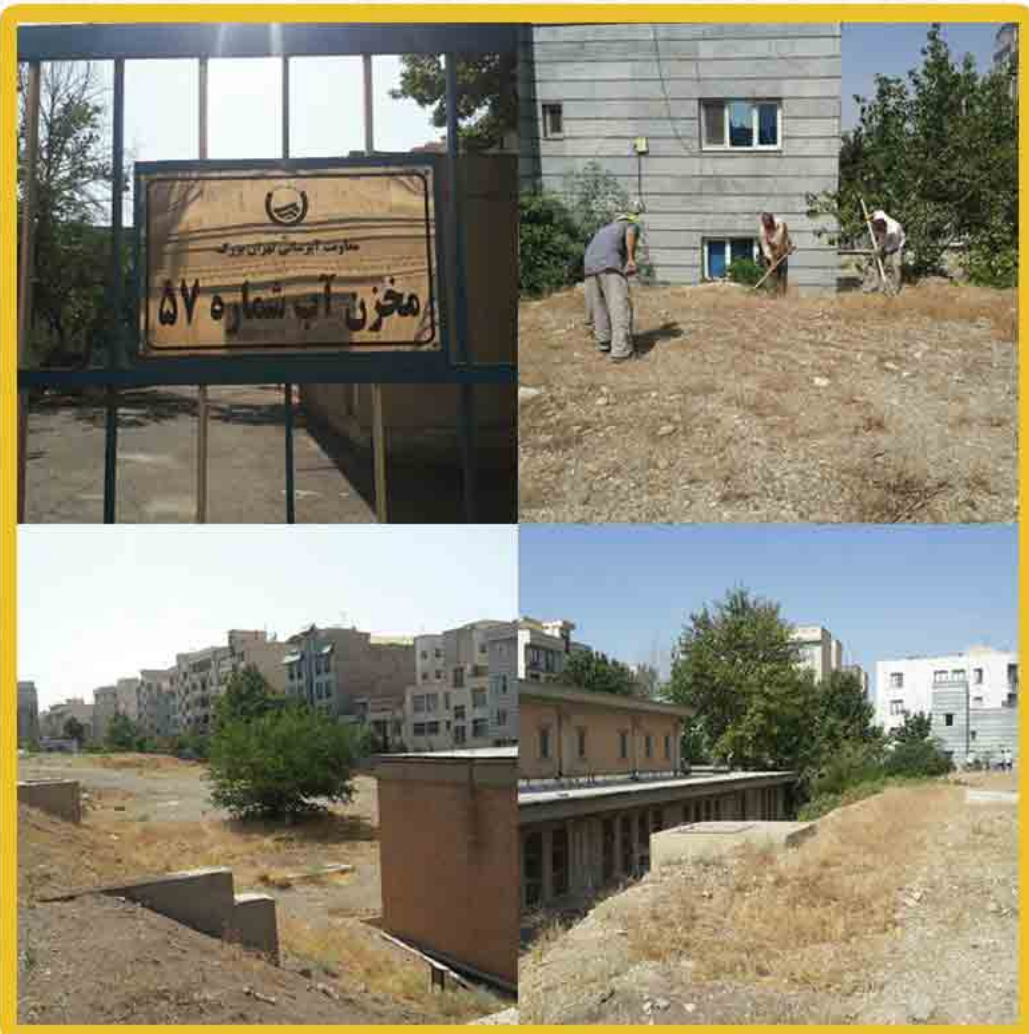
پروژه مخزن آب شماره ۵۷
