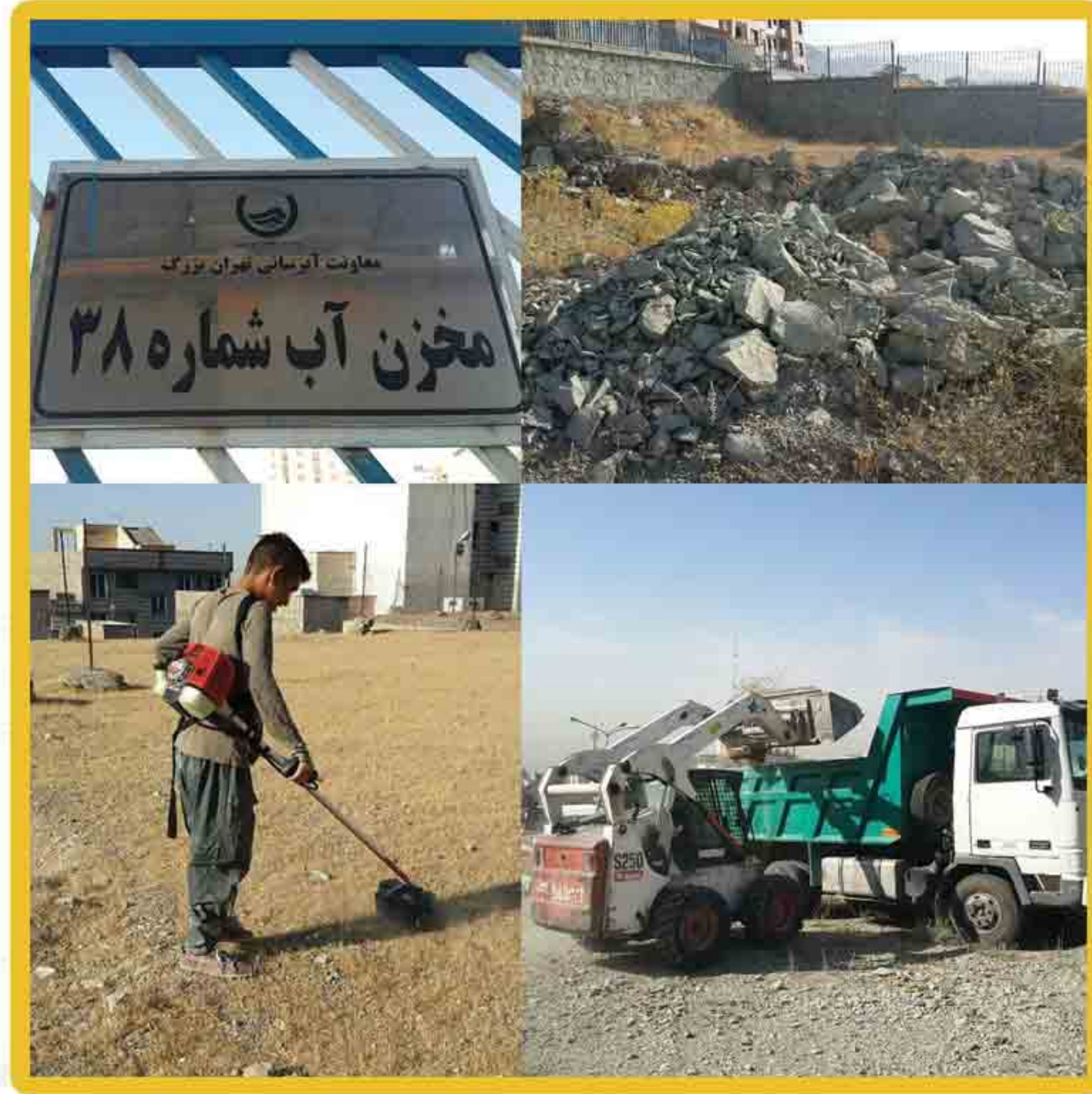
پروژه مخزن آب شماره ۳۸
